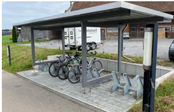
Abbildung 4: Beispiel für Anlage mit Schieberinne, beleuchtet, abschliessbar und überdacht, Foto: ewp
